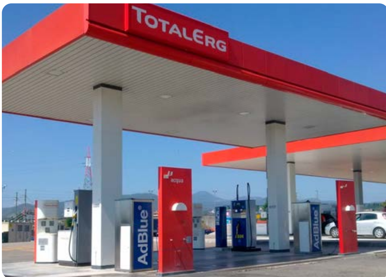
Stazione di rifornimento con erogatori AT30/UV
